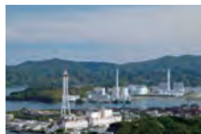
海岸沿いの施設への設置
