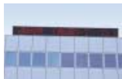
オプテックス屋上・電光掲示板
